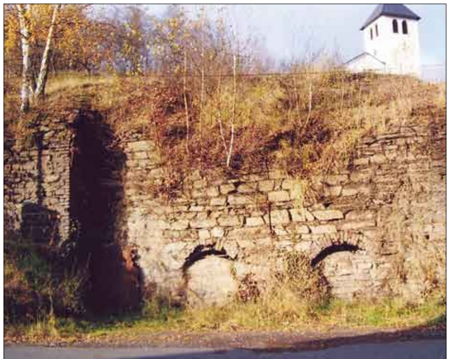
Keine gewöhnliche Stützmauer, sondern eine Röstofenanlage
